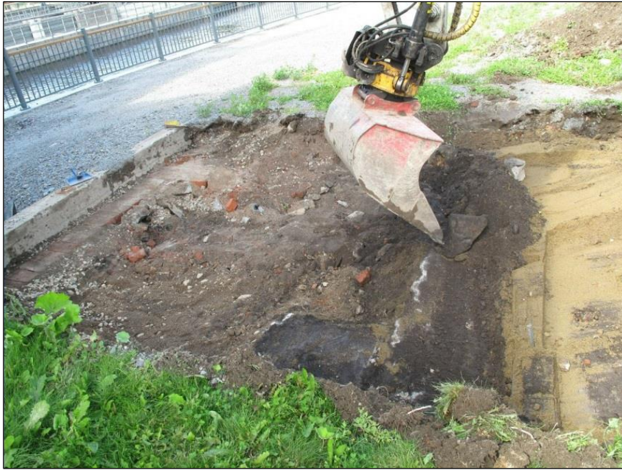
Rakenne R 161 paljastumassa.
