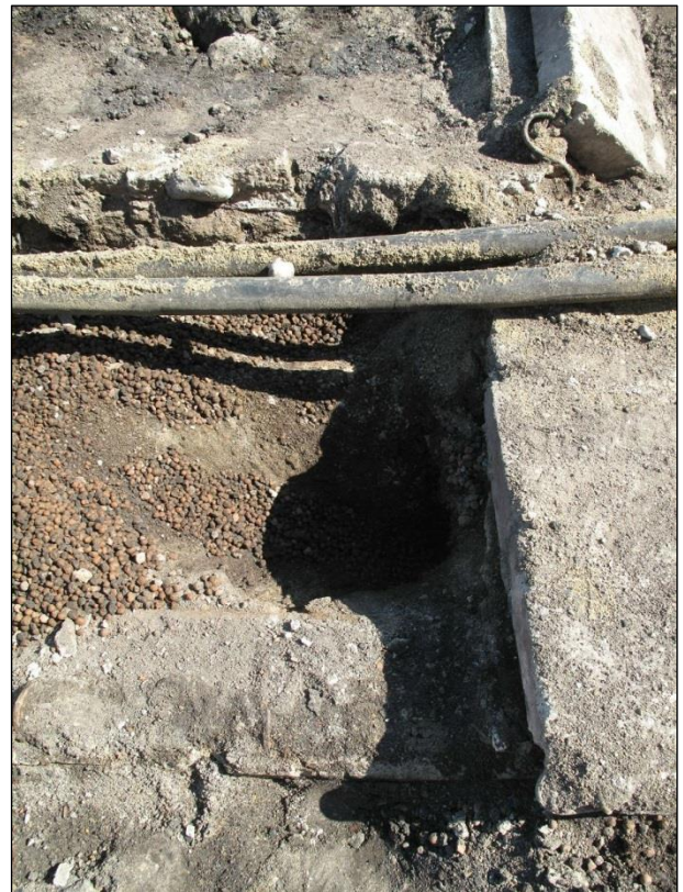
Lekasora (M 164) rakenteen R 160 sisällä.
