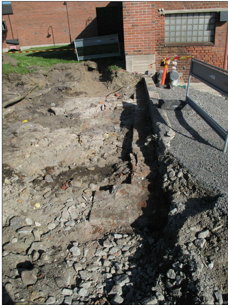
Rakenne R 161, etualalla M 163.
